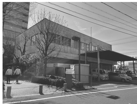
本庁舎東館 (1960年建設)
